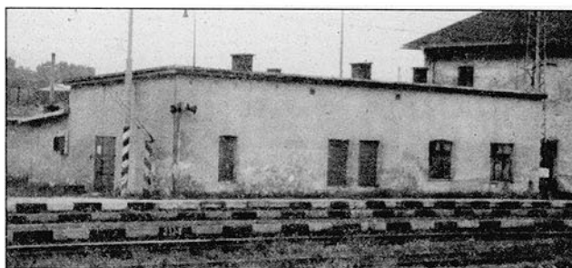
Současná podoba vodárny po adaptaci (pohled od hlavní trati)
