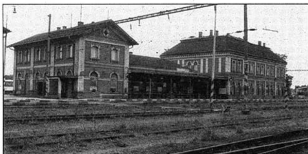
Výpravní budova z roku 1891 - celkový pohled od hlavní trati
